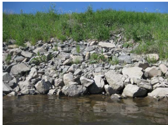
Mekanisk forbygning benyttes gjerne i utsatte skråninger, for å beskytte hus og infrastruktur. Her er det brukt sprengstein, som kan lekke næringsstoffet nitrogen og som derfor kan gi uønsket algevekst i vannet. Foto: E. Skarbøvik
