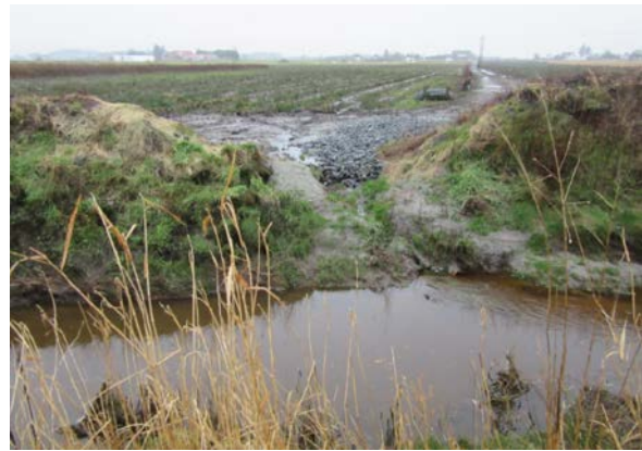
For å sikre en stabil matproduksjon blir det stadig viktigere å lede vannet bort fra åkerareal, men samtidig må vannforekomstene ivaretas. Her kunne derfor vannet fra åkeren med fordel først blitt ledet inn i en buffersone. Foto: E. Skarbøvik
