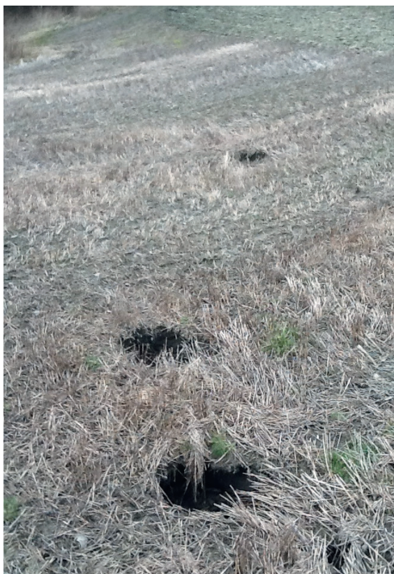
Bildegalleri 21 a-d: Tegn på at det er skader på rørledningen kan ofte sees på overflaten som jordhull eller erosjonsspor på overflaten. Noen ganger er rørledningen helt blottlagt.
