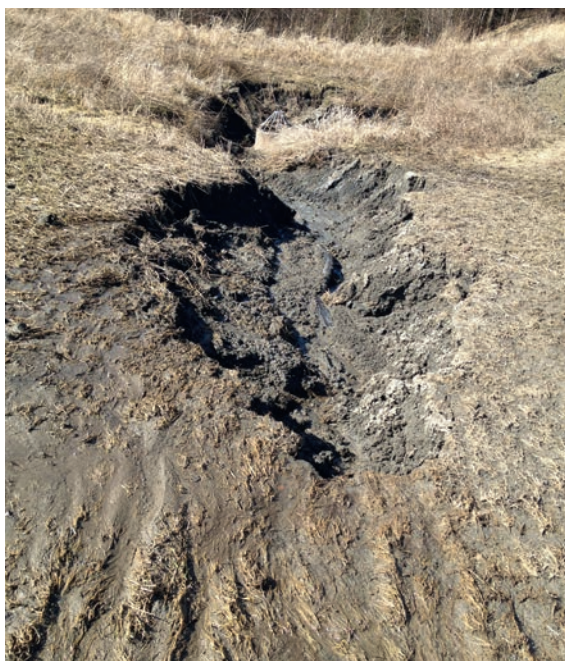
Bilde 5a: Der overflatevann renner over en fyllingskant kan en raskt få alvorlig erosjon som er vanskelig å stoppe.
