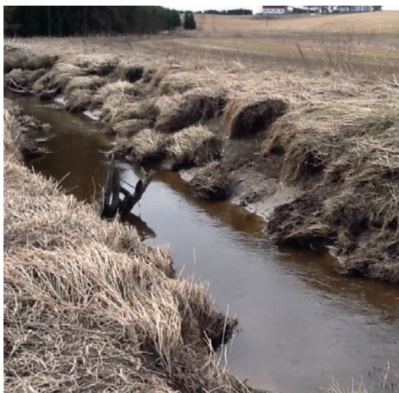
Bilde 19a og 19b: Bratte kanalsider har lett for å skli ut. Foto Atle Hauge
