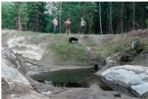
Bilde 17 a: Flomdam i utmark med begrenset utløp anlagt for å beskytte lukking nedenfor. Foto: Thorbjørn Kristiansen
