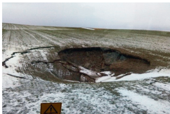
Bilde 20: Utette skjøter fører til utvasking av jord rundt røret, og etter hvert kan dette danne en stor jordhule, som til slutt kollapse.
