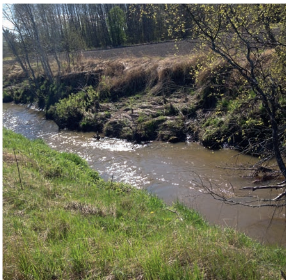
Figur 6: Ved bratte eller høye kanalsider kan en være nødt til å steinsikre nedre del for å hindre utrasing.
