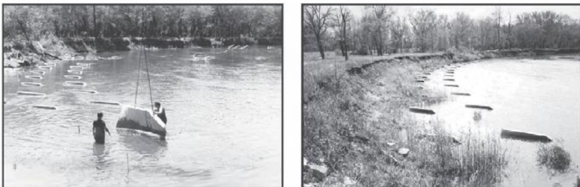
Figur 2. Eksempler på utsetting av buner i yttersving. Fra NVE Veileder nr. 4 (2009). «Veileder for dimensjonering av erosjonssikringer av stein.»
