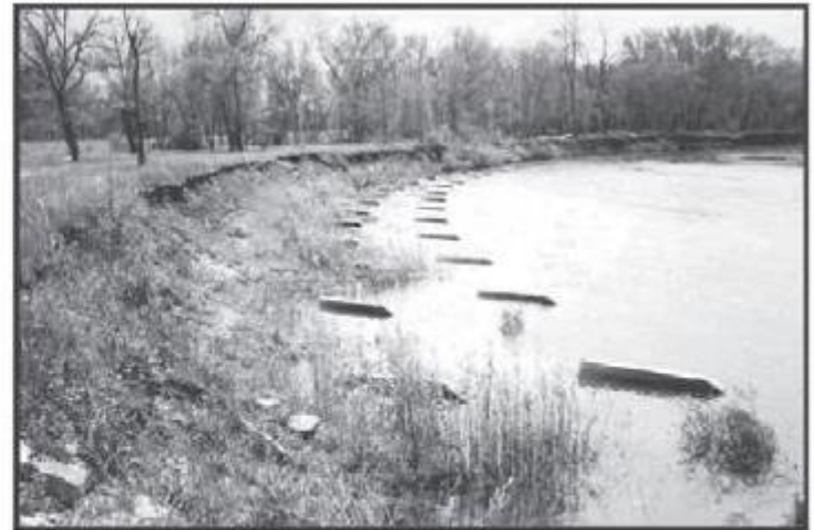
Figur 2. Eksempler på utsetting av buner i yttersving. Fra NVE Veileder nr. 4 (2009). «Veileder for dimensjonering av erosjonssikringer av stein.»
