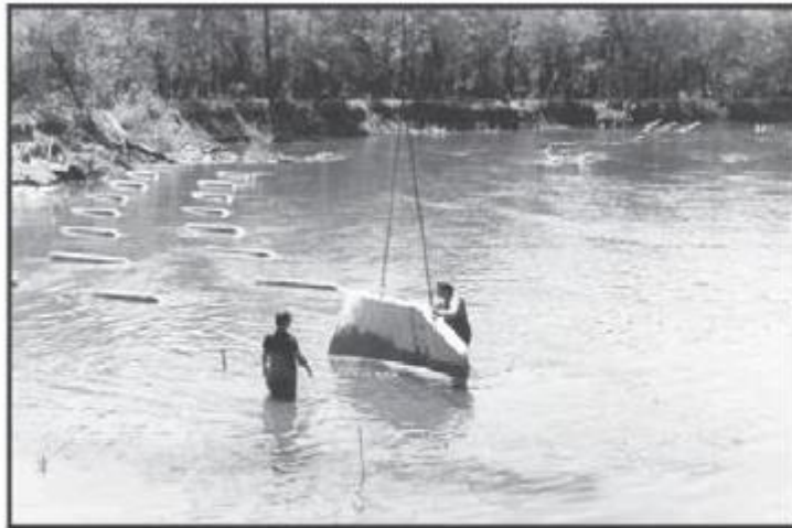
Figur 2. Eksempler på utsetting av buner i yttersving. Fra NVE Veileder nr. 4 (2009). «Veileder for dimensjonering av erosjonssikringer av stein.»
