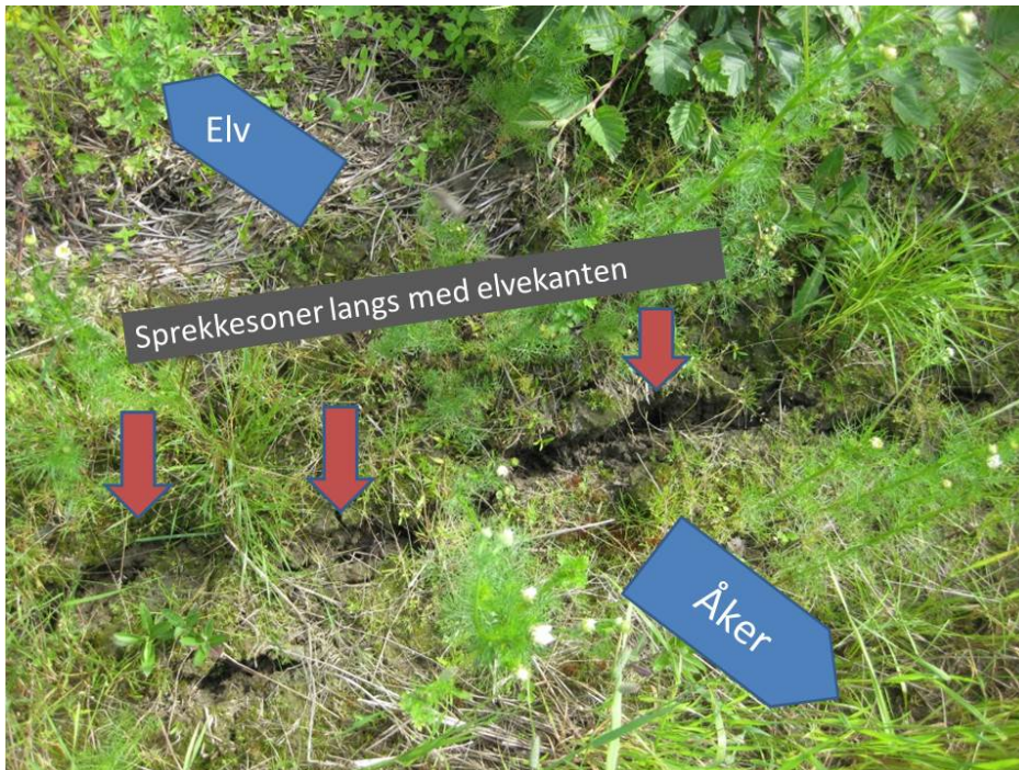
Figur 21. Eksempel på sprekkdannelse langs med elva.
