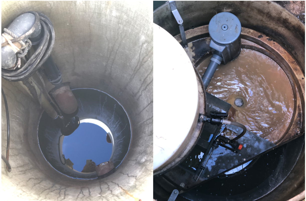
Figur 12. Wallax anlegg med etterfølgende biologisk filter. Prøvetaking skjer i pumpekum for resirkulering av vann gjennom filteret.
