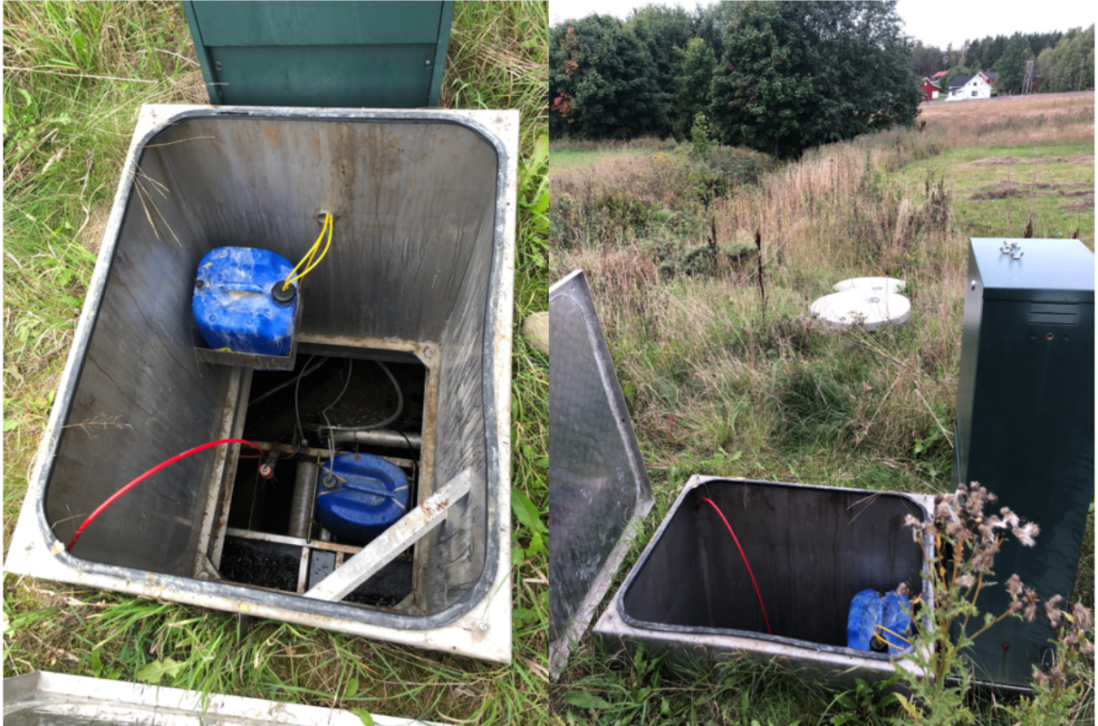
Figur 7. Odin anlegg for 15 personer. Peroxyeddiksyre tilsettes i utløpet fra anlegget foran en etterfølgende prøvetakingskum/kontakttank.
