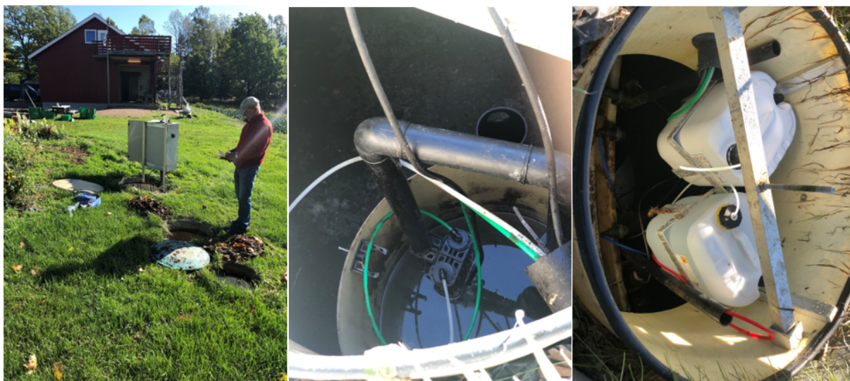
Figur 5. Biovac FD 10N anlegg for to boliger. Hydrogenperoksid tilsettes i utløp fra renseanlegget. Anlegget har en kontakttank som blir benyttet som prøvetakingspunkt.
