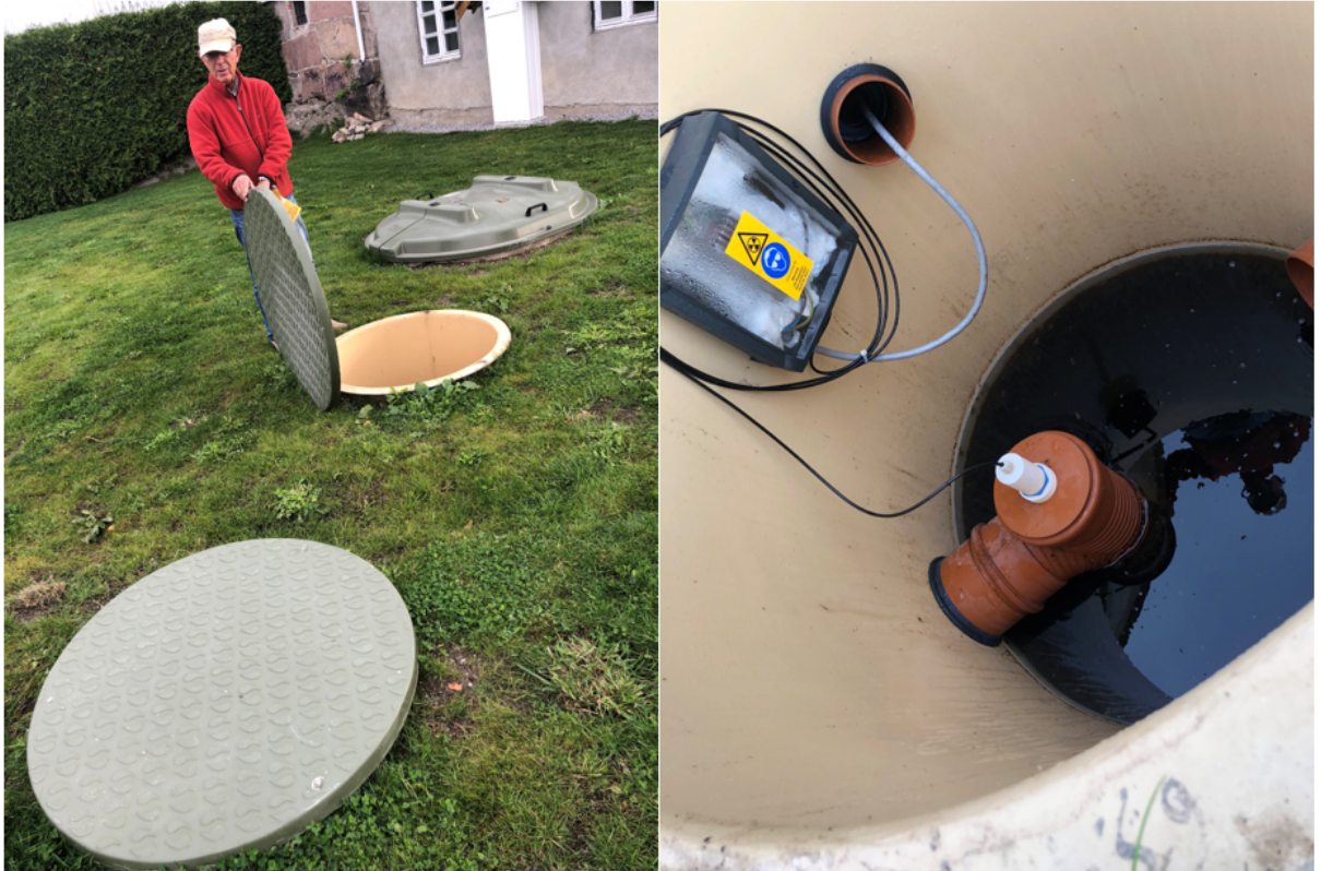
Figur 10. Klargester anlegg for en bolig. UV lampen er plassert i egen kum etter anlegget. Det er også egen kum for prøvetaking.
