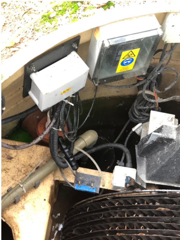
Figur 11. Klargester anlegg for en bolig. UV lamper er plassert i utløpet i selve renseanlegget.
